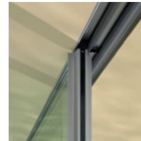
Vista da folha aberta com aro superior embutido num teto falso.
